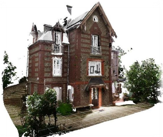
Exemple de Relevé par scanner 3D
